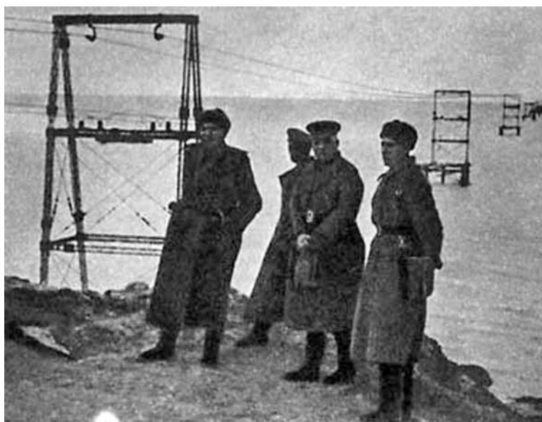
Канатная дорога через Керченский пролив. Фото: photo.qip.ru.
