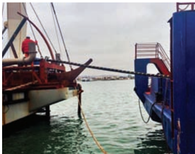
Строительство энергомоста в Керченском проливе.
