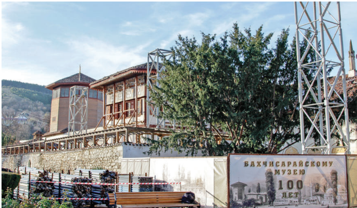
Перед заменой кровли над Южным строением возводят каркас.
