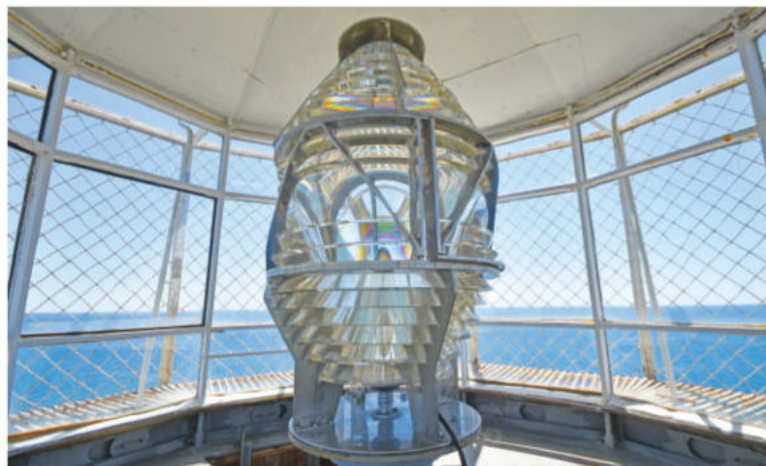
«Сердце» маяка – лампа Френеля в хрустальном светооптическом модуле.
