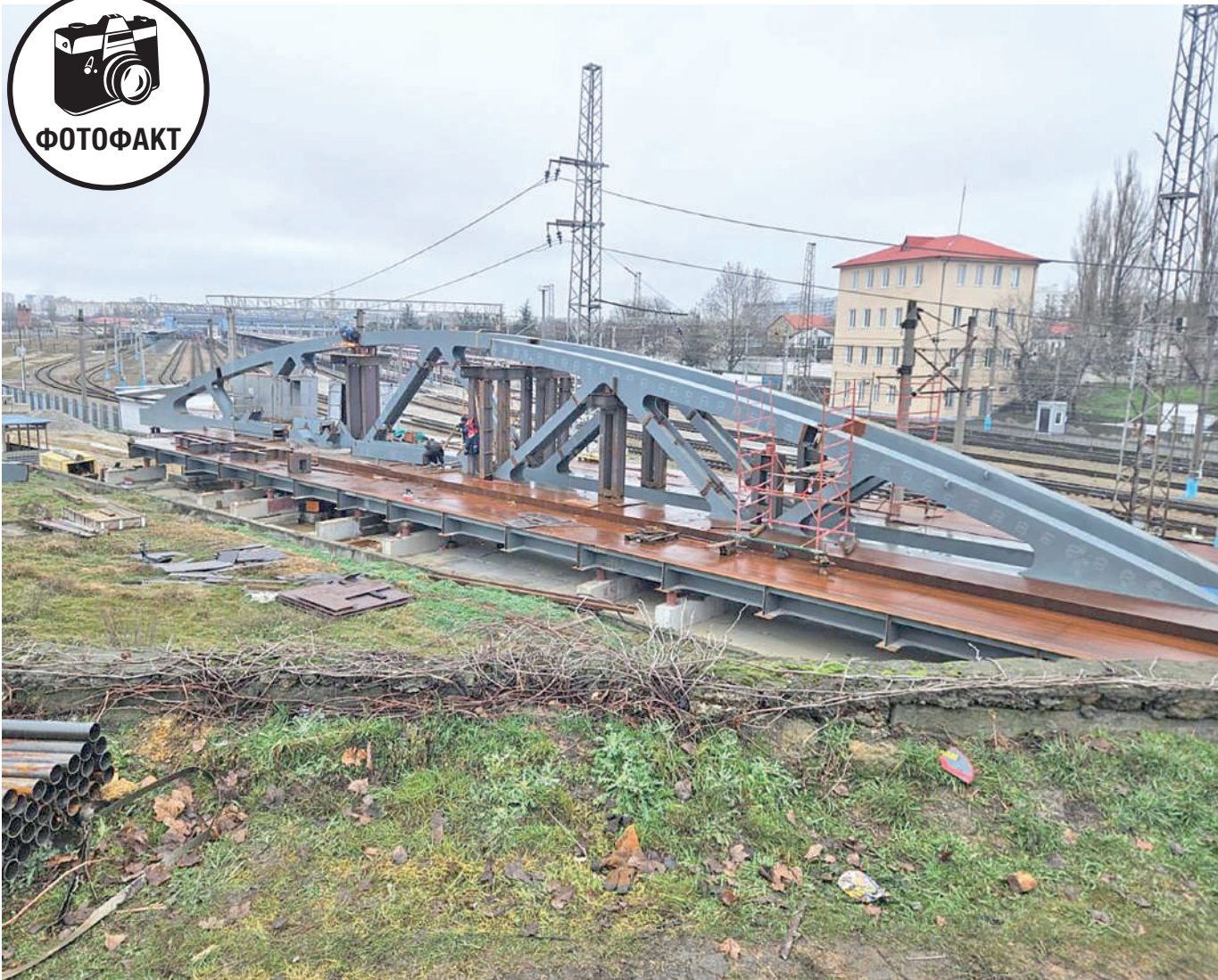
Ремонт «горбатого моста» в крымской столице идёт по графику. Фото пресс-службы администрации Симферополя.
