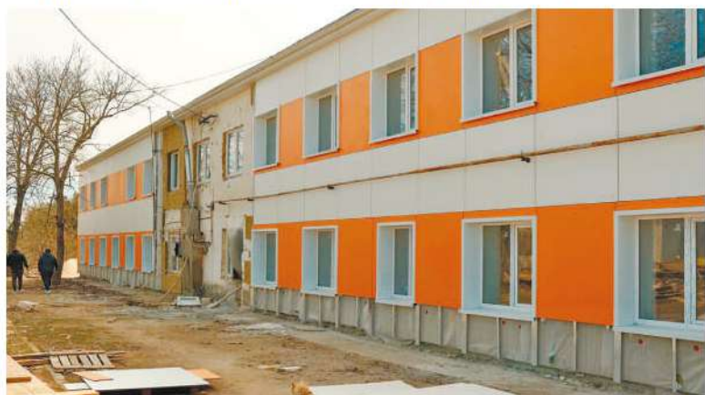
Фасадные работы на амбулатории в самом разгаре.
