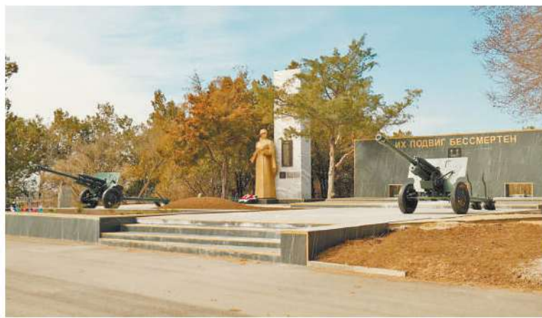
Отремонтированный мемориальный комплекс.
