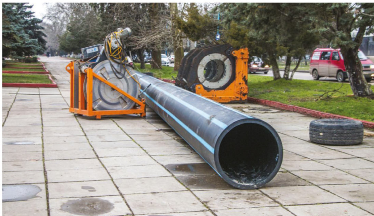
На обновление систем водоснабжения и водоотведения Керчи направили 164,8 млн рублей. Фото: пресс-служба МинЖКХ РК
