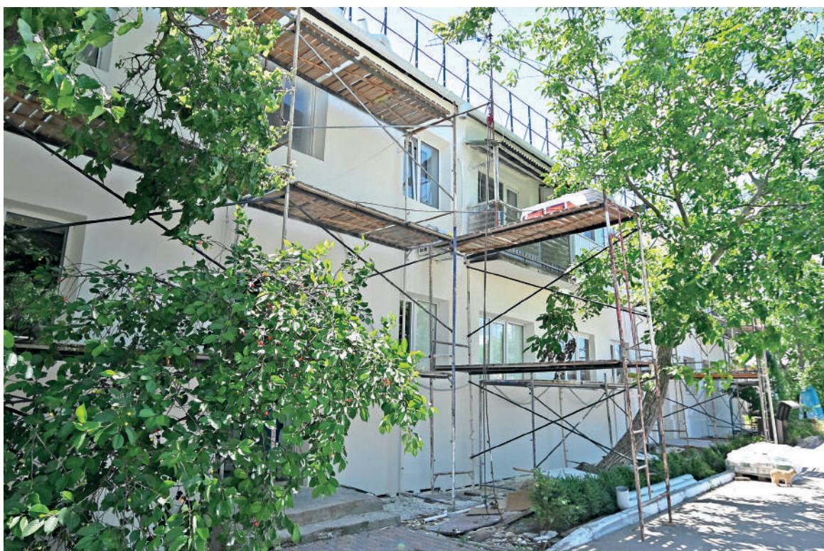
Идёт ремонт фасадов многоквартирных домов.
