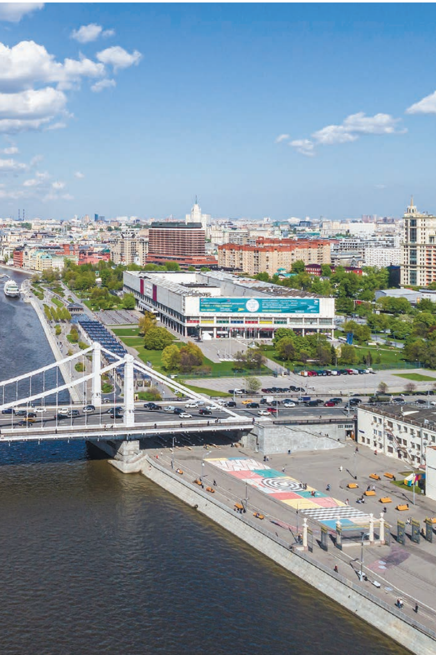
Единственный висячий мост через Москву-реку – Крымский.
