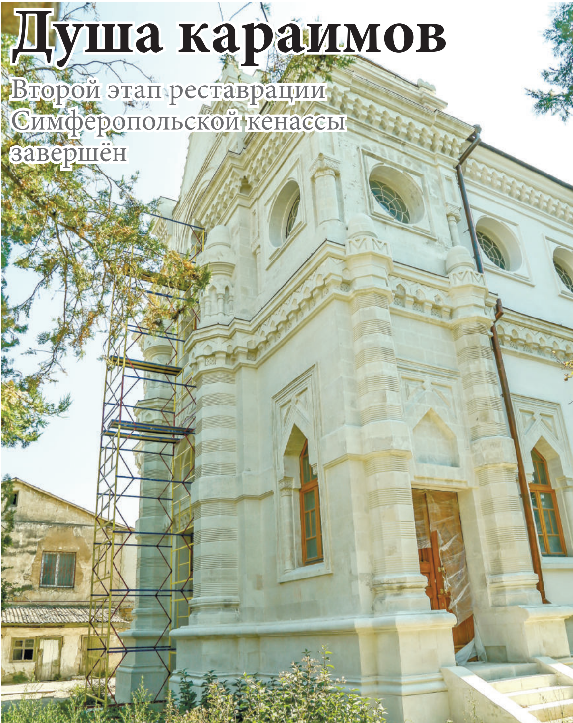
Строительные леса снаружи здания почти убраны. Реставраторы завершают последние детали.
