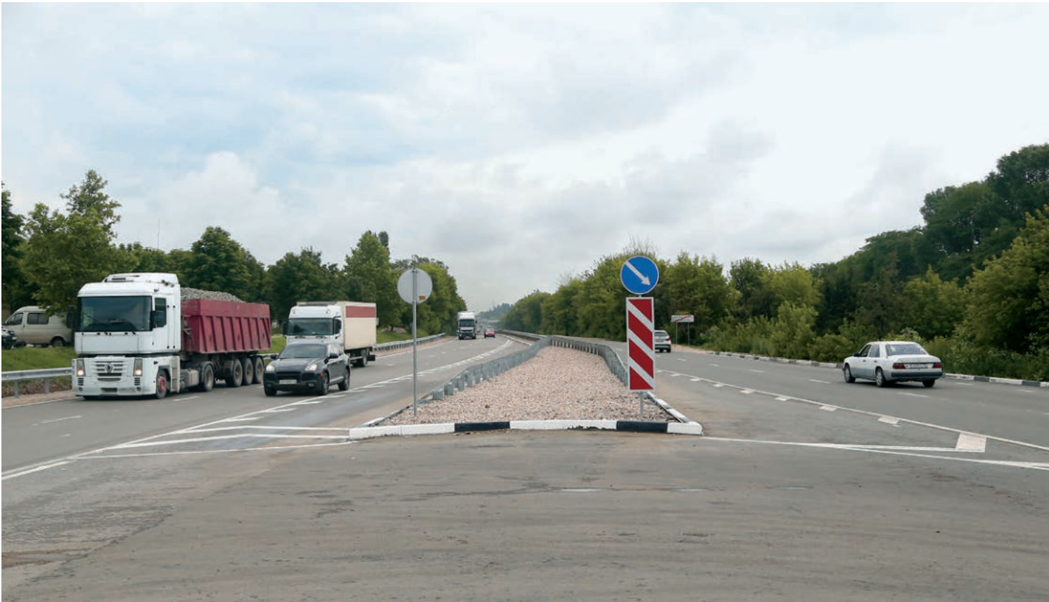
Разделительная между полосами дорог для эстетики и удобства эксплуатации на новоотремонтированных участках сделана из щебня. Это техническое решение в САД хотят применять и в дальнейшем. Фото: Владимир ПРОШКИН
