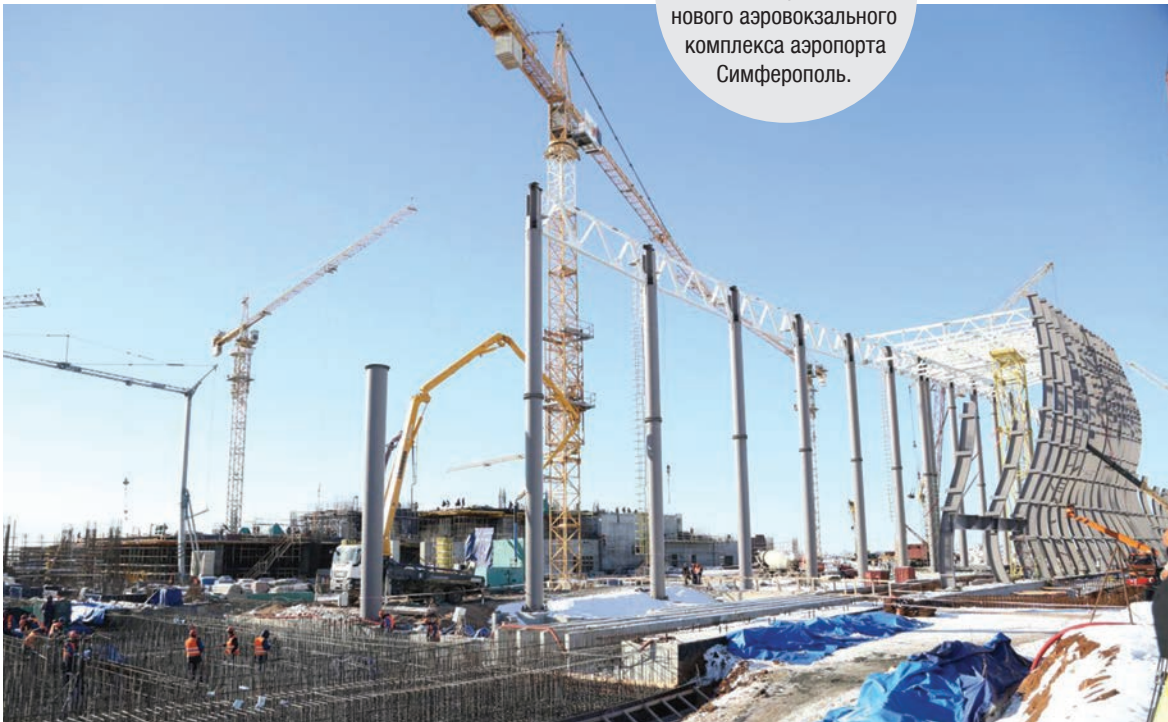
Каркас «Крымской волны» возводят круглосуточно в две смены. Фото: Владимир ПРОШКИН
