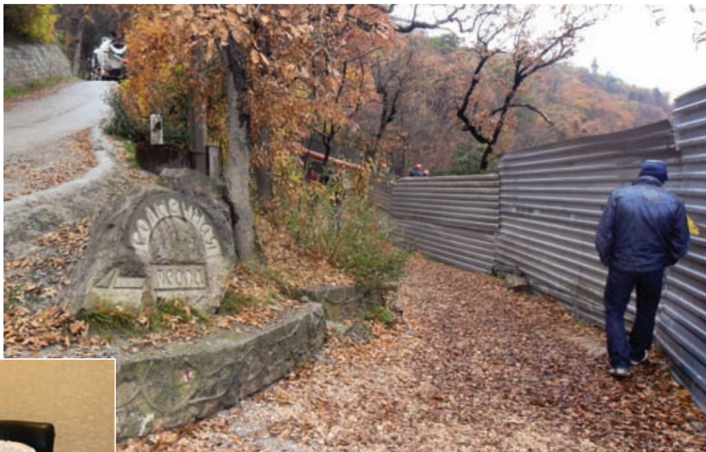
Оползень в 2013 году перекрыл Царскую тропу. В этом году ситуация повторилась.
