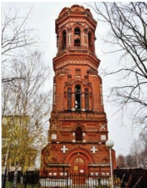
Алатырь, полуразрушенная Казанская (Пятницкая) церковь.
