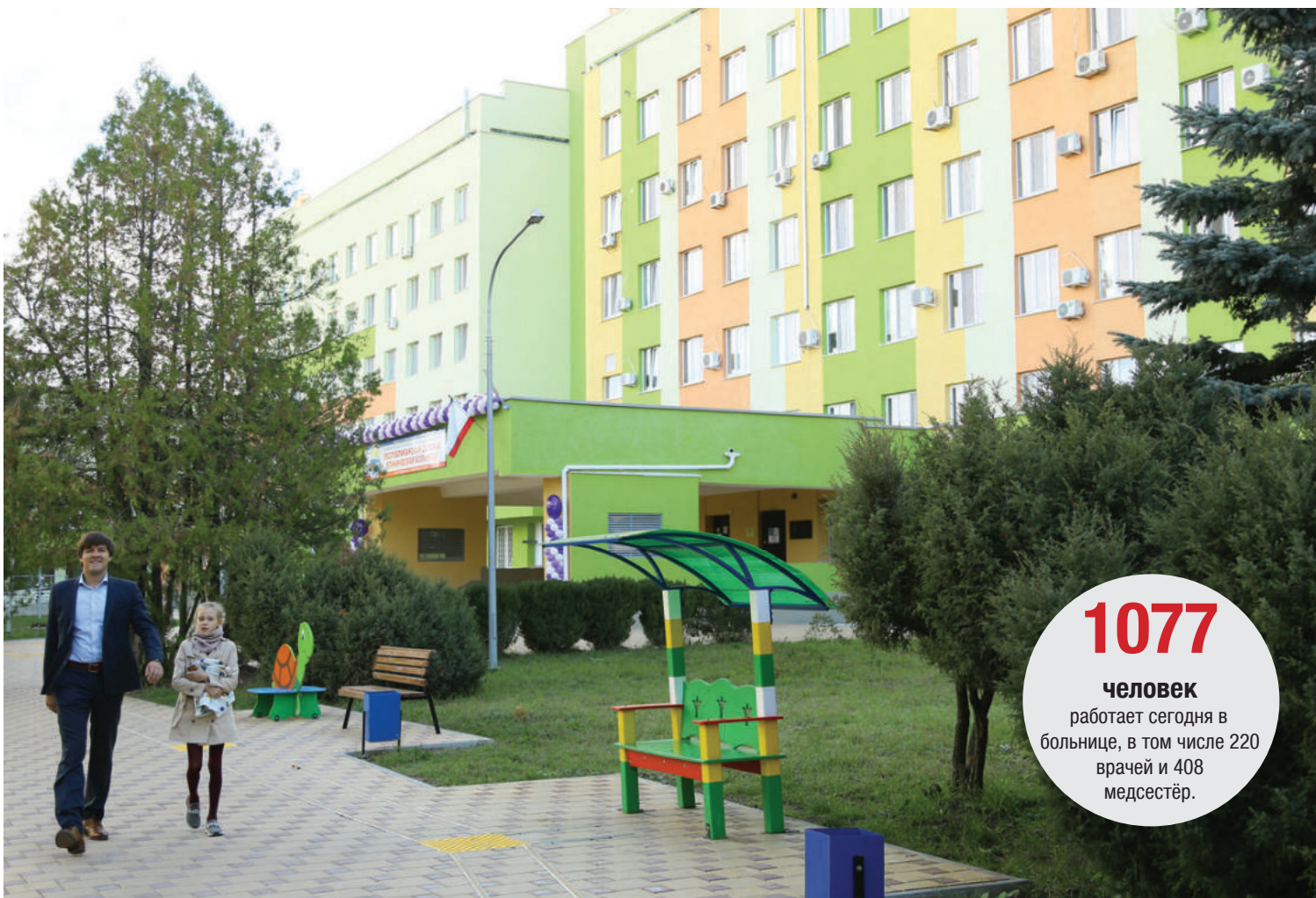
После ремонта здание больницы преобразилось. Фото: Лидия ВЕТХОВА
