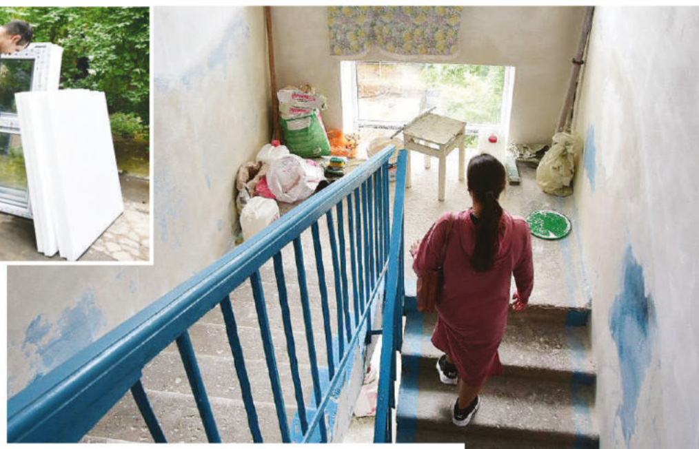
В подъездах дома № 126 на ул. Киевской работы завершены наполовину.
