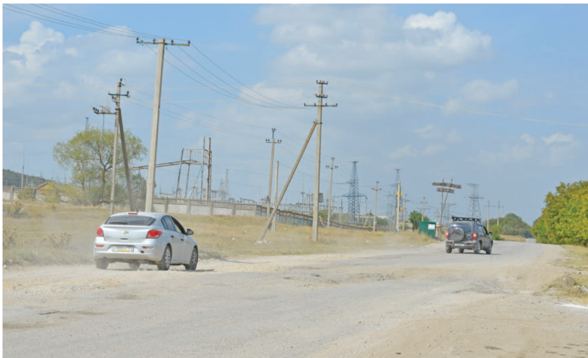
Этот разбитый участок дороги обещают отремонтировать в ближайшее время.
