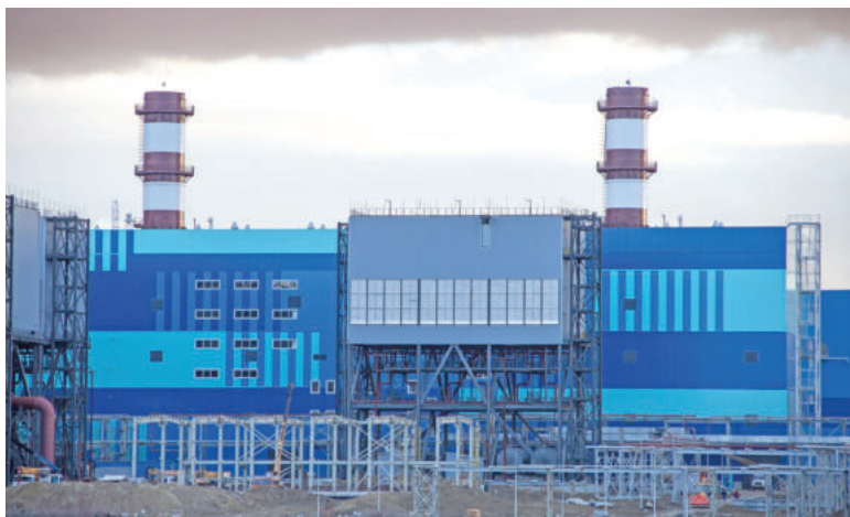
Оба блока Симферопольской ПГУ-ТЭС, расположенной в районе Денисовки, планируют ввести в эксплуатацию уже этой осенью. Фото: Михаил ГЛАДЧУК
