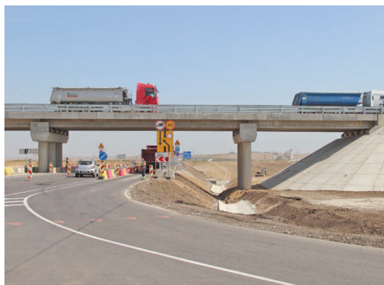
Строителям предстоит возвести 18 транспортных развязок, 29 путепроводов в теле дороги, 23 путепровода для проезда с/х техники и 15 путепроводов на съезде транспортных развязок, а также 18 мостов. Над дорогой также построят 30 надземных пешеходных переходов.
