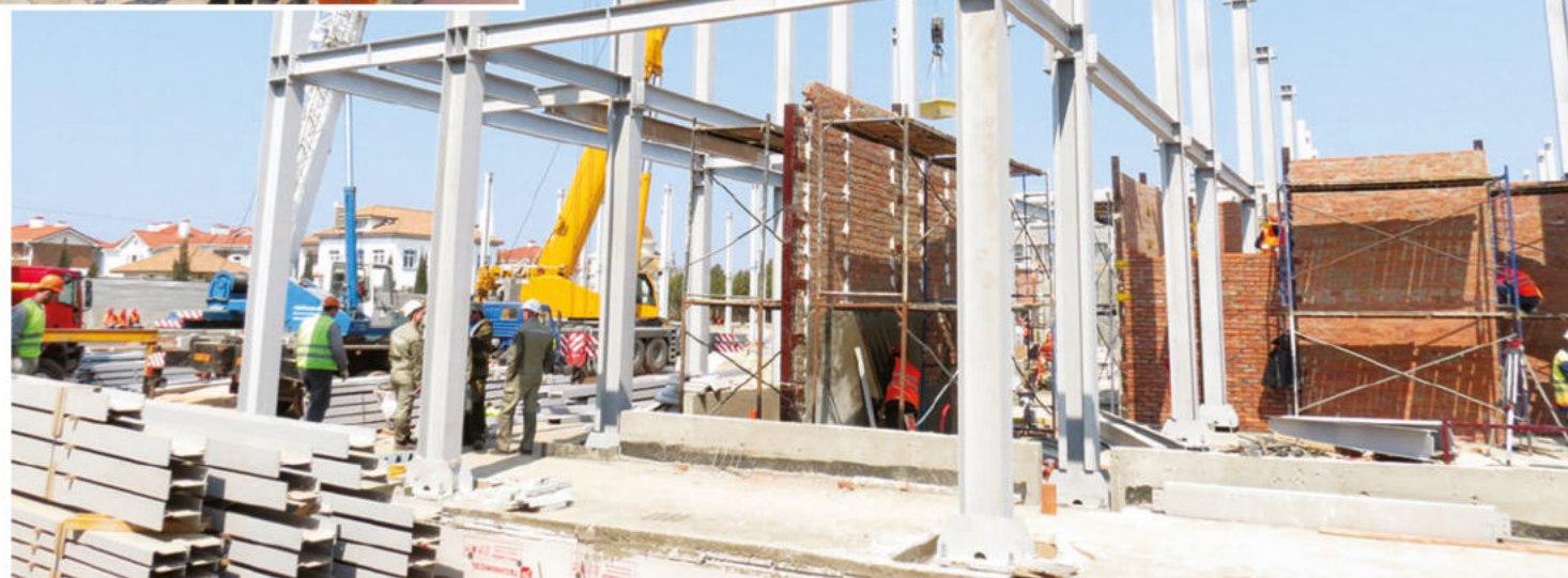
На строительной площадке многофункционального медицинского центра в Севастополе. Здесь же развёрнута столовая для строителей. Фото автора
